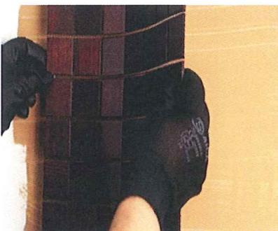
➤ Дождавшись полного высыхания клея (примерно сутки), поэтапно заполнить швы эпоксидной затирочной смесью Litokol (или KERAKOLL) снизу вверх, поперек швам (расход 800-1000 г/м<sup>2</sup>).
